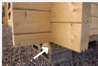
Drilled in threaded rod for wind safety Eingeborte Gewindestange En las esquinas varillas de rosca Barras de Refuerzo (Parafusos Sem Cabeça) Tiges filetes anti-tempete Barra filettata per foratura Draadeinden in de wand verwerkt
