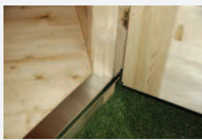
Stainless steel doorill Edelstahl-Türschwelle Franja de umbral de la puerta con lamina de acero inoxidable Faixa de entrada coberto com chapa de aço inoxidável Seuil de porte arasant avec plancher habillé inox Soglia del portone in inox RVS dorpel Próg drzwi ze stali nierdzewnej
