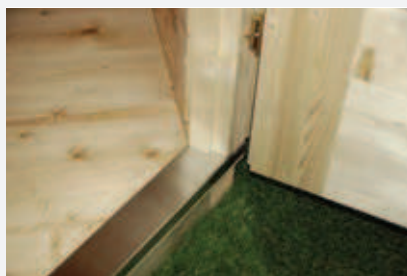
Stainless steel doorill Edelstahl-Türschwelle Franja de umbral de la puerta con lamina de acero inoxidable Faixa de entrada coberto com chapa de aço inoxidável Seuil de porte arasant avec plancher habillé inox Soglia del portone in inox RVS dorpel Próg drzwi ze stali nierdzewnej
